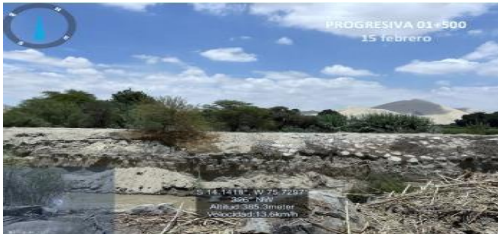
FIGURA N°02: SE OBSERVA EL DETERIORO DEL TALUD QUE REQUIERE DE LIMPIEZA Y DESCOLMATACION
