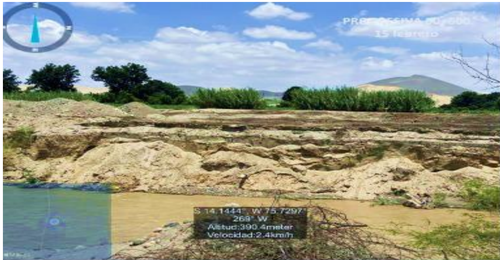
FIGURA N°01: TRAMO CRÍTICO EN EL RIO ICA COLMATADO CON EROSION EN LA MARGEN DERECHA PARA MANTENIMIENTO DEL CAUCE
